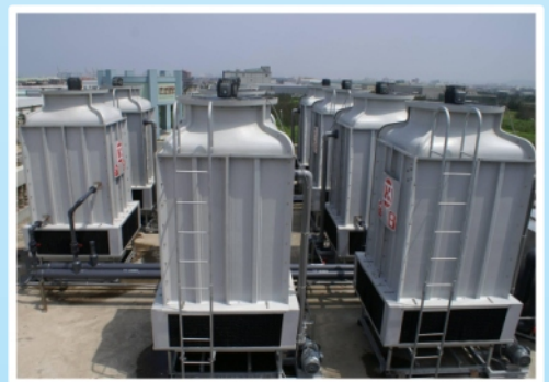
日本積水塑膠 SEKISUI PLASTICS CO., LTD.
